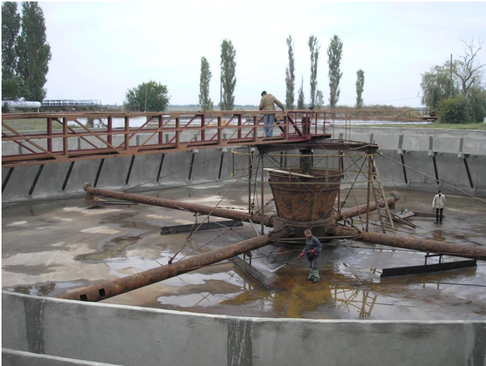
Фото 7. МКП «Миколаївводоканал», вторинний відстійник Галицинівських очисних споруд каналізації
