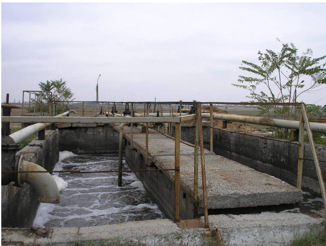
Фото 5. МКП «Миколаївводоканал», аеротенки Галицинівських очисних споруд каналізації
