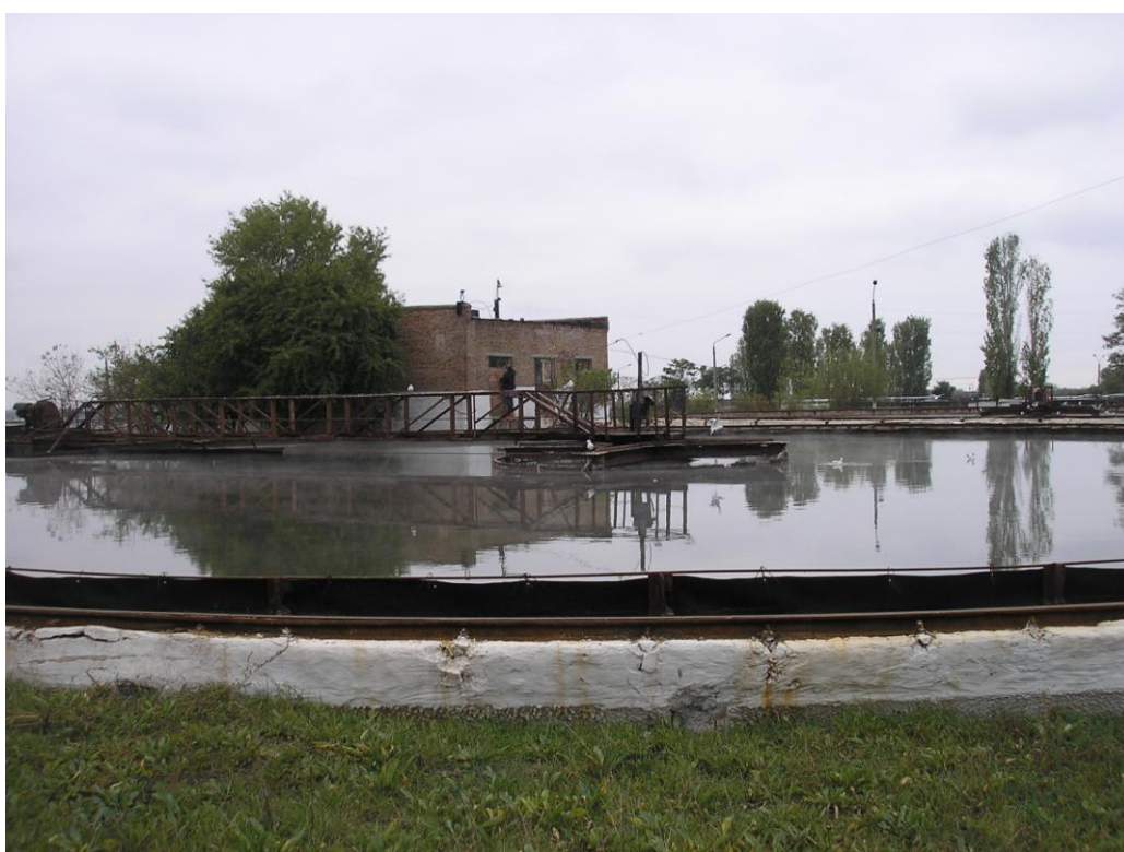
Фото 6. МКП «Миколаївводоканал», вторинний відстійник Галицинівських очисних споруд каналізації
