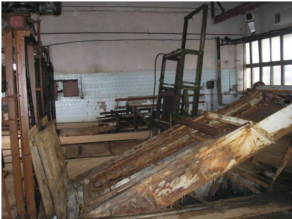
Фото 8. МКП «Миколаївводоканал», цех механічної очистки Галицинівських очисних споруд каналізації
